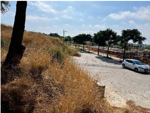
nº 5 Extrem de ponent a on s'aprecia el talús
