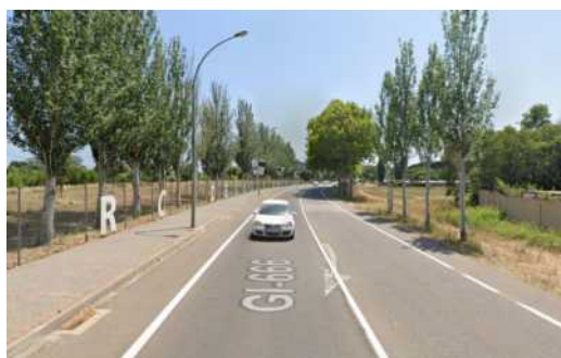
Figura 4.30.– Tram de la carretera GI-666 al seu pas per Castell-Platja d'Aro.
