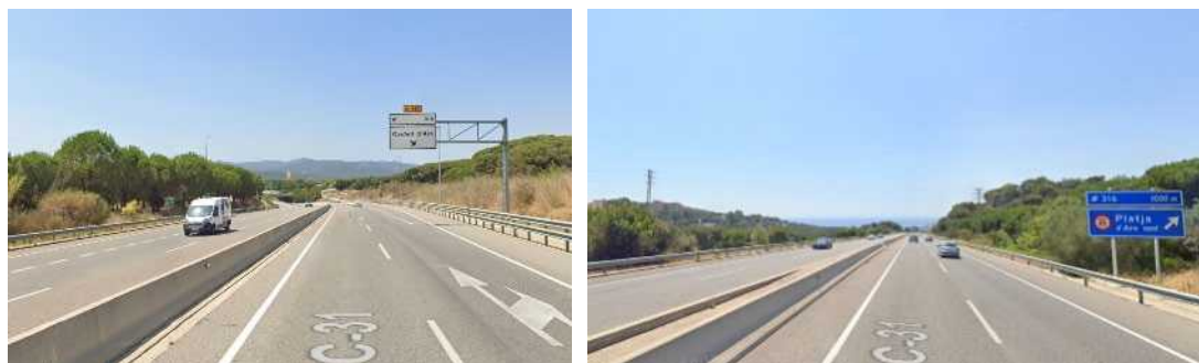
Figura 4.27.– Trams de l'autovia C-31 a l'alçada de Castell d'Aro (esquerra) i a l'alçada de la urbanització Mont d'Aro (dreta).
