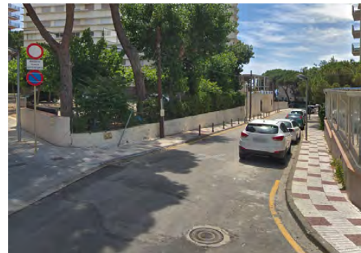
Pal de fusta existent a connectar-se
