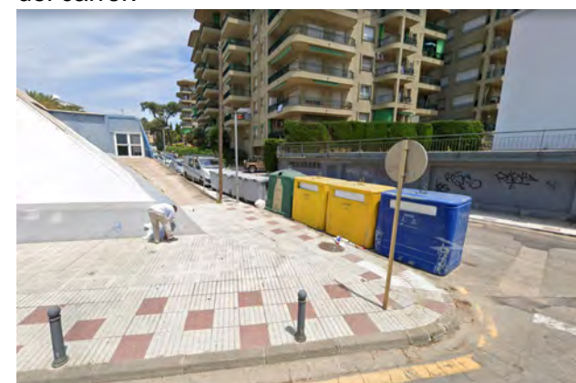
Pal de fusta, existent en el sector, línia a soterrar
